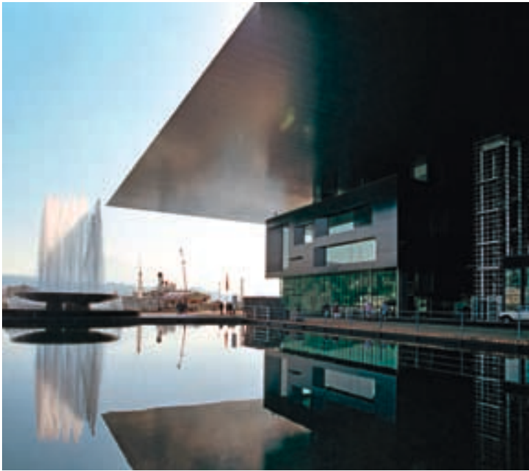
«Flying Roof» des Kultur- und Kongresszentrums Luzern (KKL) realisiert mit Alucore Verbundplatten von 3A Composites.
